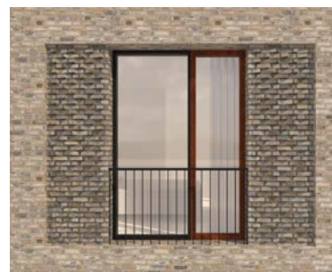
Eksempel på vindue med stående vindusfag i antracitgrå lakeret stål/alu ramme og gående fag i hårdtræ
