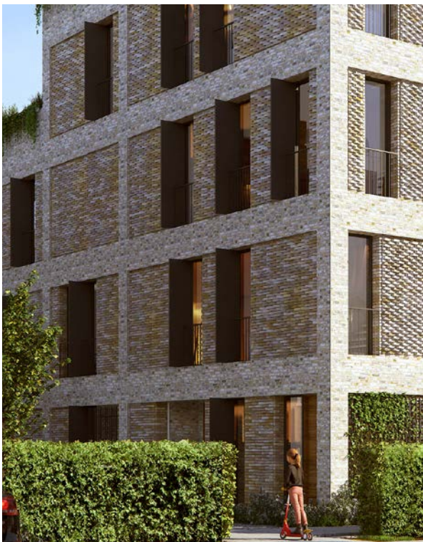
Vinduer i nordlige facade, udføres med skodder der fremstår som en integreret del af vinduet
