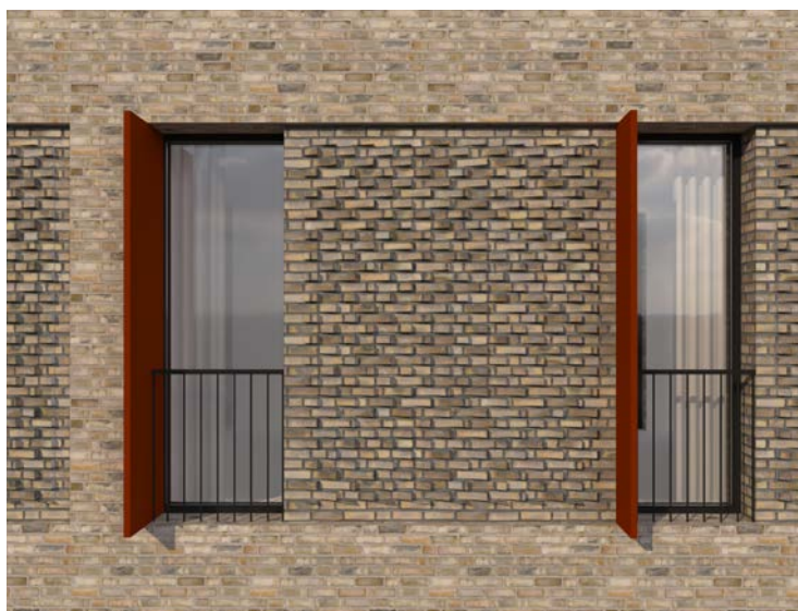
Vindue og skærm nordfacade kombination lakeret / Ral 7016 / Corten
