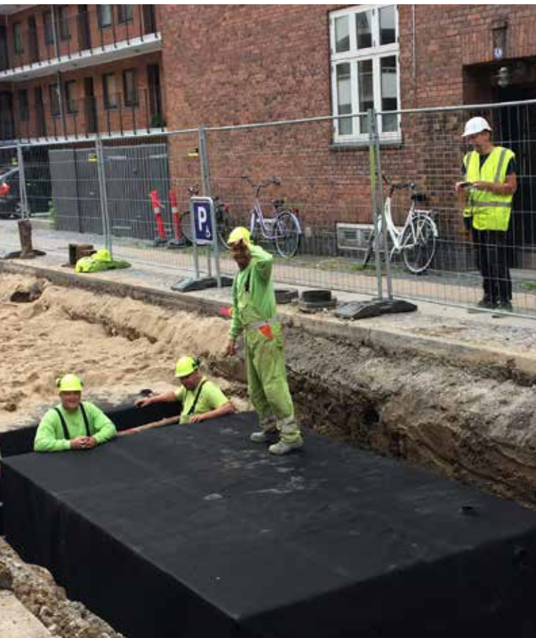
Anlæg af punktvis regnvandshåndtering på Holger Danskes Vej
