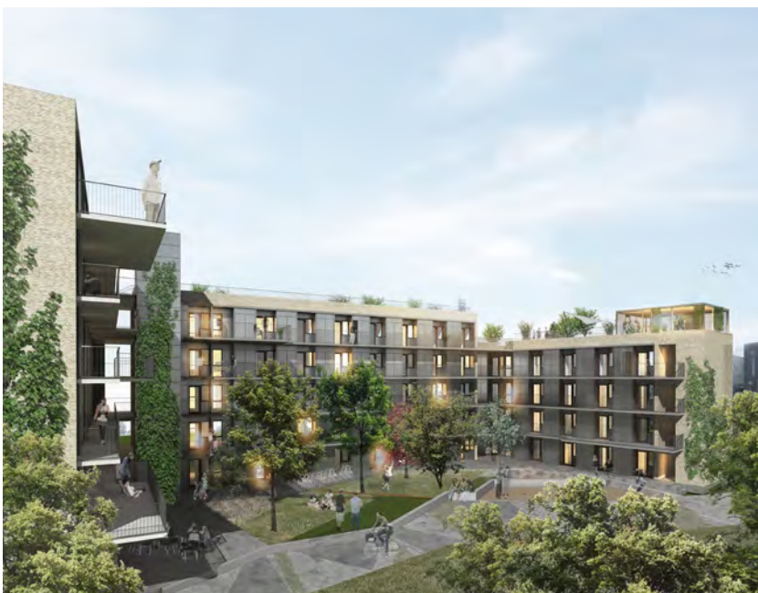
Den nye bebyggelse set fra gårdsiden
