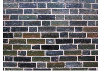
Eksempel på glaseret tegl som kan bruges i dele af stueetagens facade.
