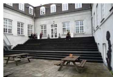
Eksisterende tagterrasse beliggende på gymnastiksal
