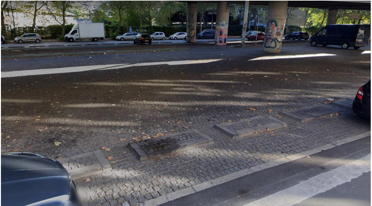
Figur 5. Areal under Bispeengbuen. På billedet fremgår de store mængder af chaussesten som er lagt under Bispeengbuen. (Stationering 400). Kilde: Rambøll.
