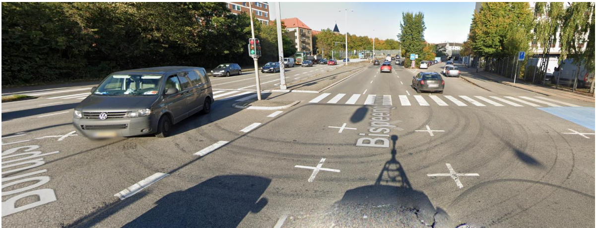
Figur 6. Vej areal og midterrabbat. På billedet fremgår vejarealet og midterrabbatten som leder op til Bispeengbuen og udgør en stor del af den asfalt som opbrydes. (Stationering 0). Kilde: Rambøll.
