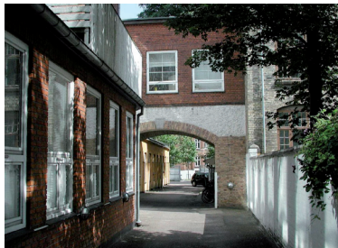
Erhvervsbygningen, som ikke er bevaringsværdig kan nedrives.
