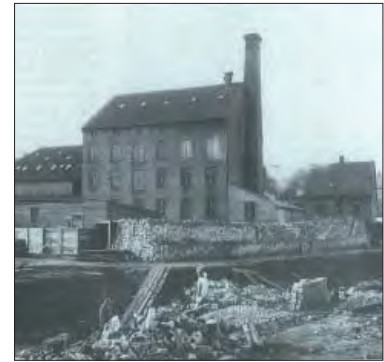
Det tidligere garveri var lukket, og kun dele af bebyggelsen stod der endnu. I forgrunden ses udgravning til arkitekt E. Blichfeldts store etageejendom på hjørnet af Åboulevard og H. C. Ørsted Vej. Foto ca. 1898 - By-museet.
