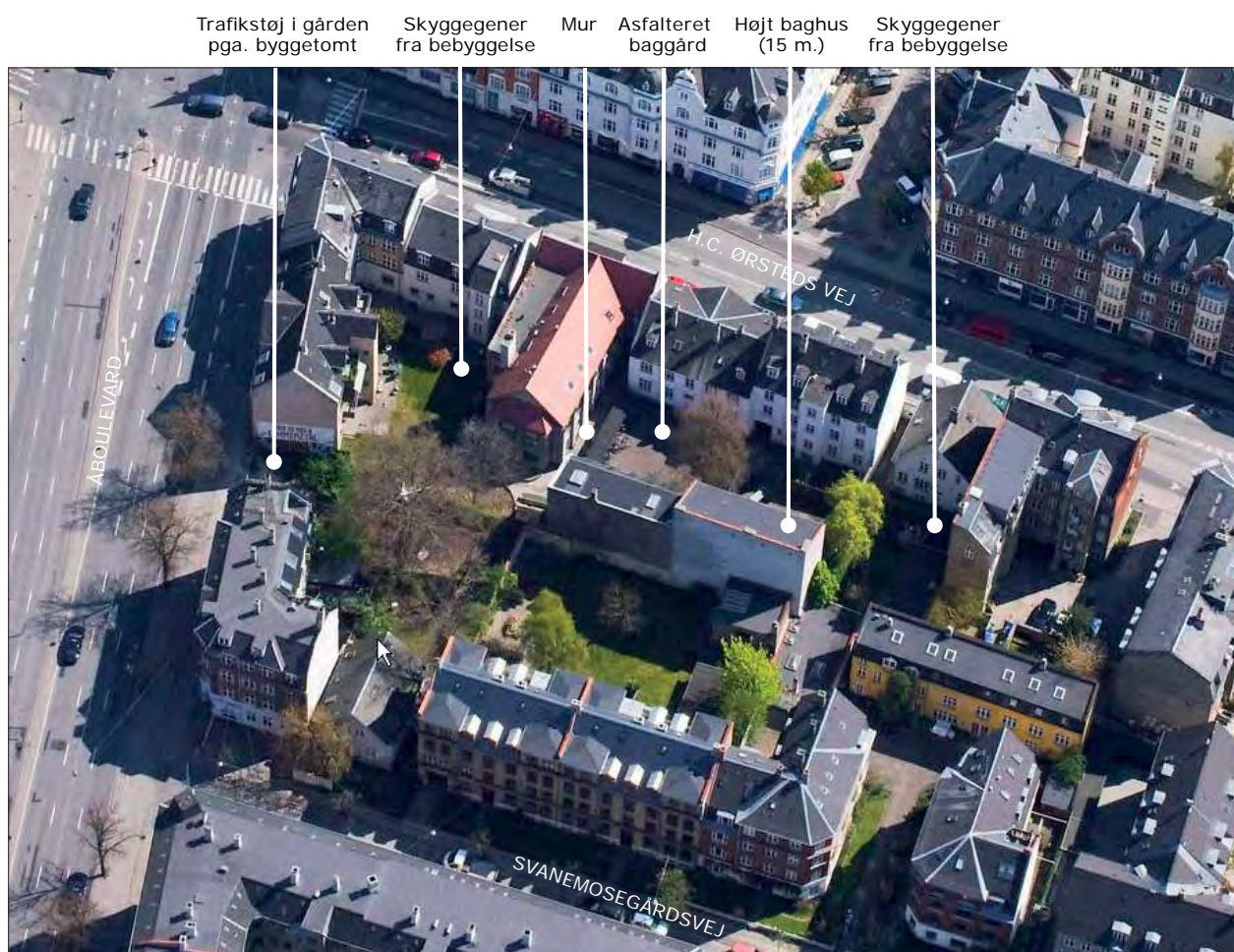
Skråfoto af eksisterende forhold i den nordlige del af karréen ved H.C. Ørsteds Vej, Svanemosegårdsvej og Åboulevard.
