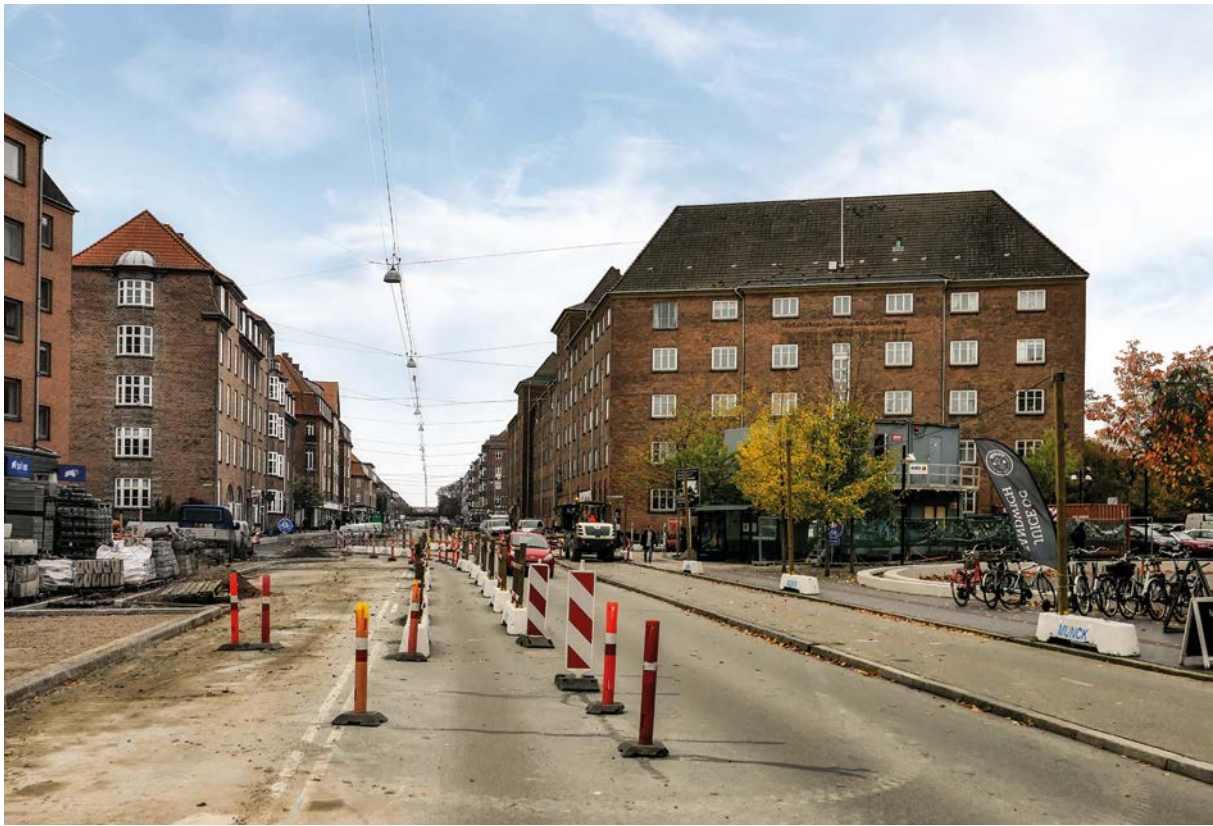
Fra Peter Bangs Vej mod vest - eksisterende forhold
