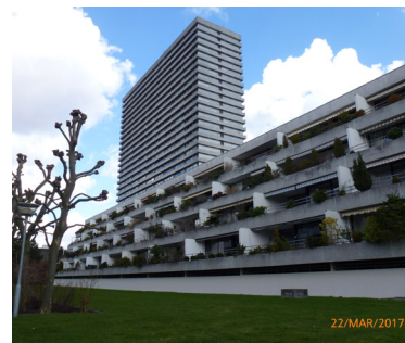
Terrassehuse langs Betty Nansens Allé. Domus Vistas høje tårn i baggrunden.
