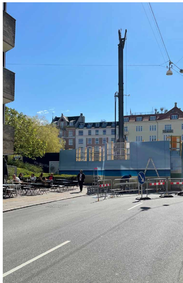
← Etablering af arbejdsskakt på Vodroffsvej.
