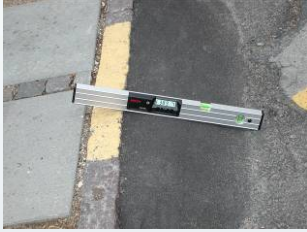
Rampe, som er for stejl
