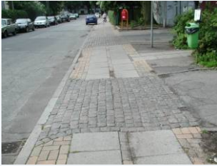
Gangbane afbrudt af brosten
