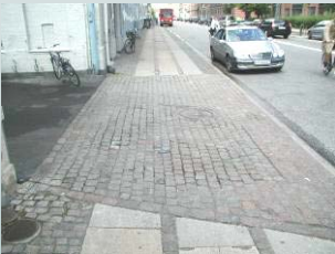
Afbrudt gangbane, brosten
