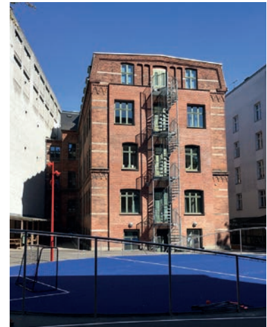
Baghus bygning C, som forudsættes nedrevet
