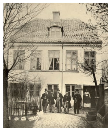
Værnedamsvej 5, forlystelsesstedet Rosenlund. ca. 1865.
