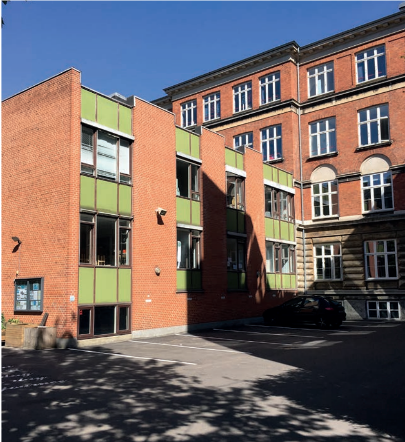
Foto: Frederiksberg Allé 22 - Bygning B med tilbygning fra 1972
