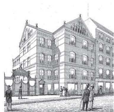
Illustration fra år 1899 af bygning C og port, Værnedamsvej 13B
