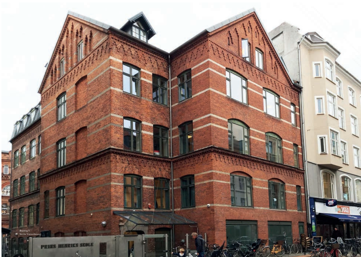
Foto: Værnedamsvej 13B - Bygning C
