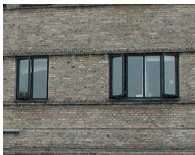
Efter 1930: Samme facadeudtryk til gade og gård på Godthåbsvej 114-116. Både gade og gård i blank mur med fremtrukne murstensbånd over og under vinduer. Funktionel tradition.
