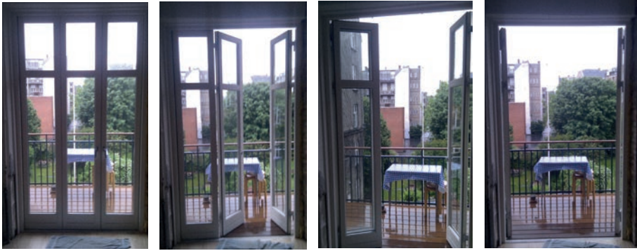
Fra venstre til højre ses foldedøren gå fra lukket til åben position.
