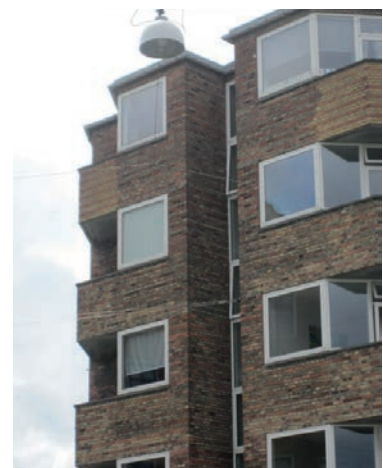
På Finsensvej 61 er altanværnene en integreret del af murværket.
