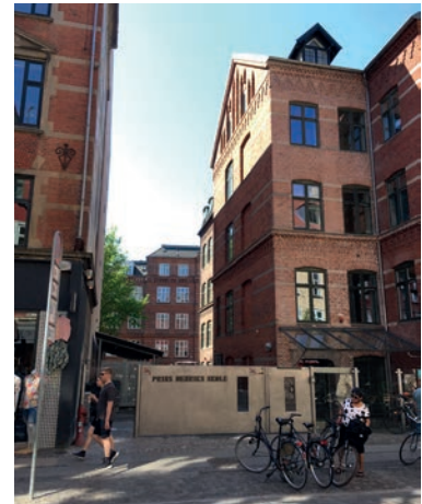
Adgang fra Værnedamsvej via Smøgen som ved lokalplanens udarbejdelse er spærret med sikkerhedshegn
