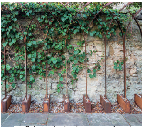
Cykelparkering langs grøn facade.
