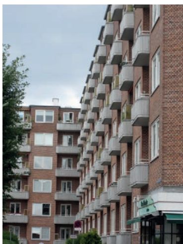
Til venstre: Finsensvej 89-99 med indeliggende dobbeltaltaner med støbt værn og muret afskærmning. Stokbebyggelse placeret vinkelret på vejen. Til højre: Julius Valentiners Vej 1-11 med påhængte altaner og støbte værn mod et U-formet underum ud til vej.
