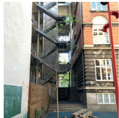
Frederiksberg Allé 22 er via trappe og elevator bygget sammen med nr. 16
