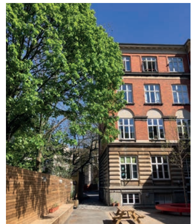
Passage mellem skel og nordlige gavl Frederiksberg Allé 22
