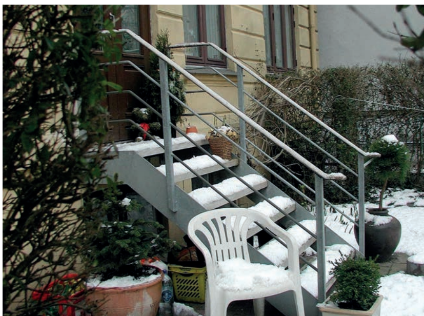
Mathildevej 18 med ny havedør og nedgang til have. Ståltrappen muliggør, at kældervindue beholdes intakt.
