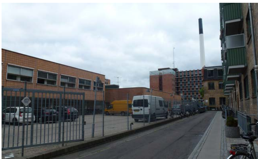
9: Post Danmarks bygning i 1-2 etager bliver nedrevet i forbindelse med opførelsen af Start-up City. Adskillelse med hegn og affaldscontainere mellem postbygningen og boligkarréen mod øst forudsættes fjernet.
