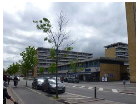
3: Den modernistiske Krystalgården med vandrette altangange og lodrette skalmursfacader.
