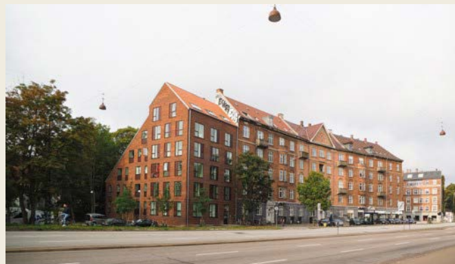
To kommunale grunde blev i 2018 udbudt til byggeri af almene boliger, hvoraf 50% var til flygtninge. AAB's 16 boliger på Falkoner Alle 128 blev taget i brug i 2020
