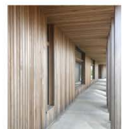
Træliste beklædning og beton søjler i kolonnade
