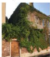
Facade i stue- etage begønnes
