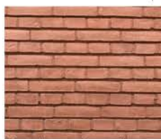
Mursten og fuger i samme røde nuance
