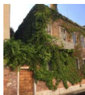
Facade i stue- etage begønnes
