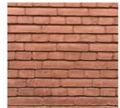
Mursten og fuger i samme røde nuance
