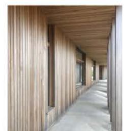
Træliste beklædning og beton søjler i kolonnade
