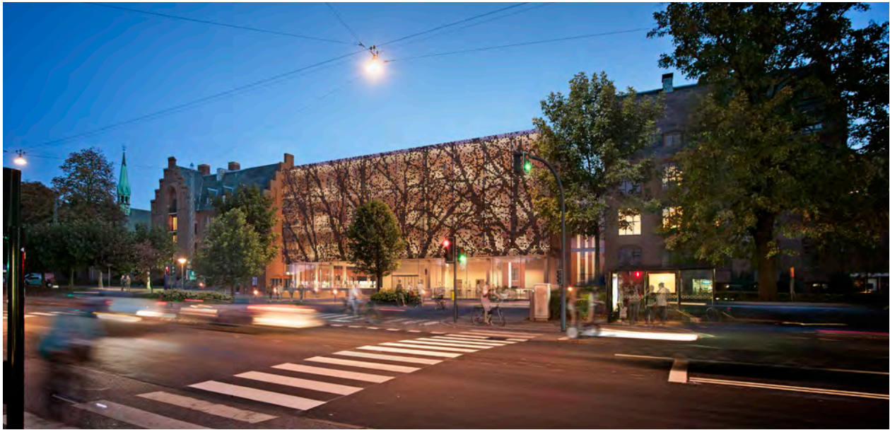
Sundhedshuset facade vil fremstå foranderlig og får en særlig karakter om aftenen, når huset bliver belyst indefra. Set fra Peter Bangs Vej.
