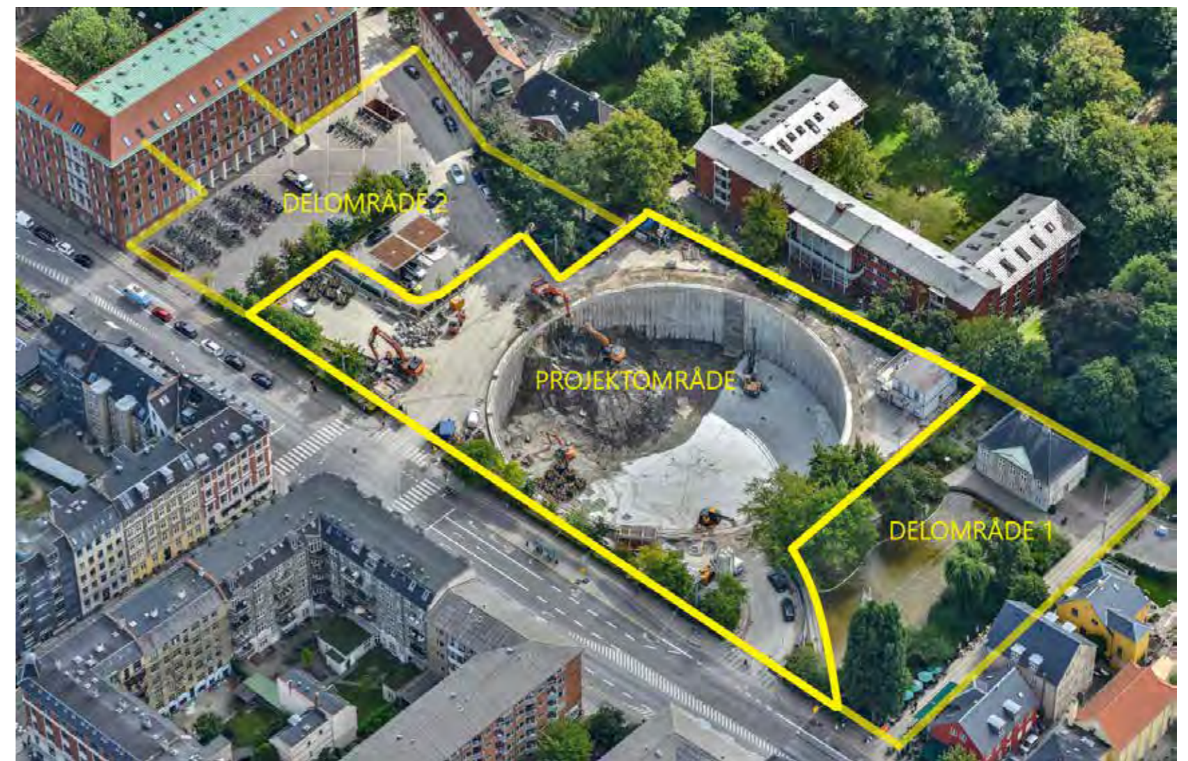
Dronofoto 2022 - inddeling af projektområder. Dispositionsforslaget arbejder med projektområde + delområde 1, samt lille del af Delområde 2 ved transformerstationerne ved kollegiet. (foto fra udbudsmateriale)
