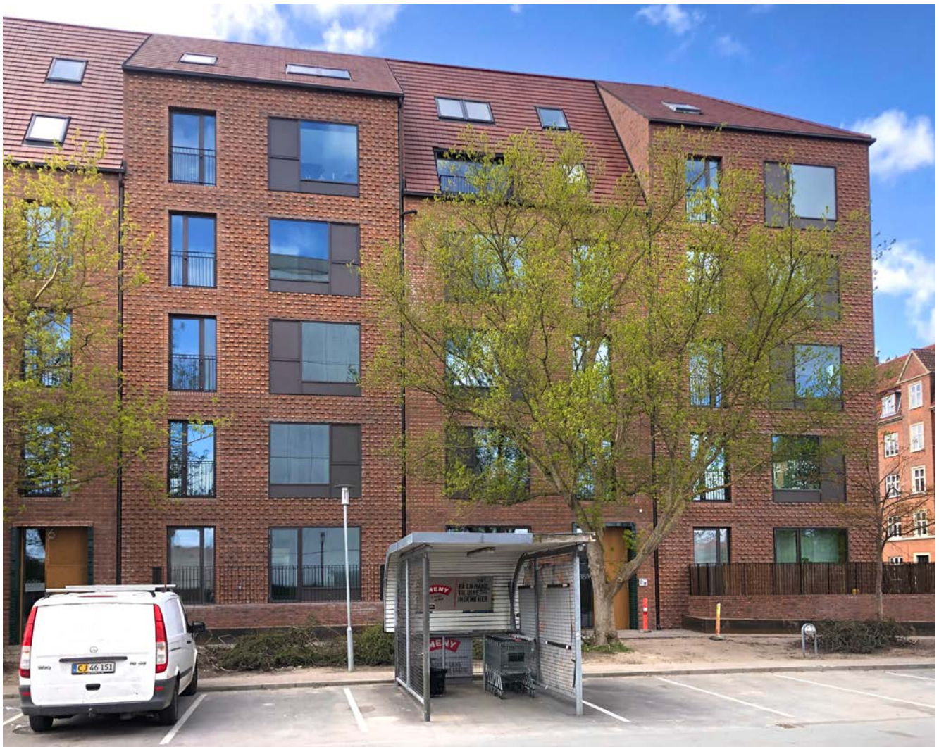
Fuglebakkevej 88 - Modtog Frederiksberg Kommunes Bygningspræmi-ering 2023. Opført af ejendomsselskabet Fuglebakkevej 88-90 Frederiksberg ApS og tegnet af Effekt Arkitekter. I byggeriet er arbejdet med forskellige bæredygtige tiltag, som f.eks at integrerede solceller i tagfladen mod syd, der har samme farve som de mørkerøde tagsten.
