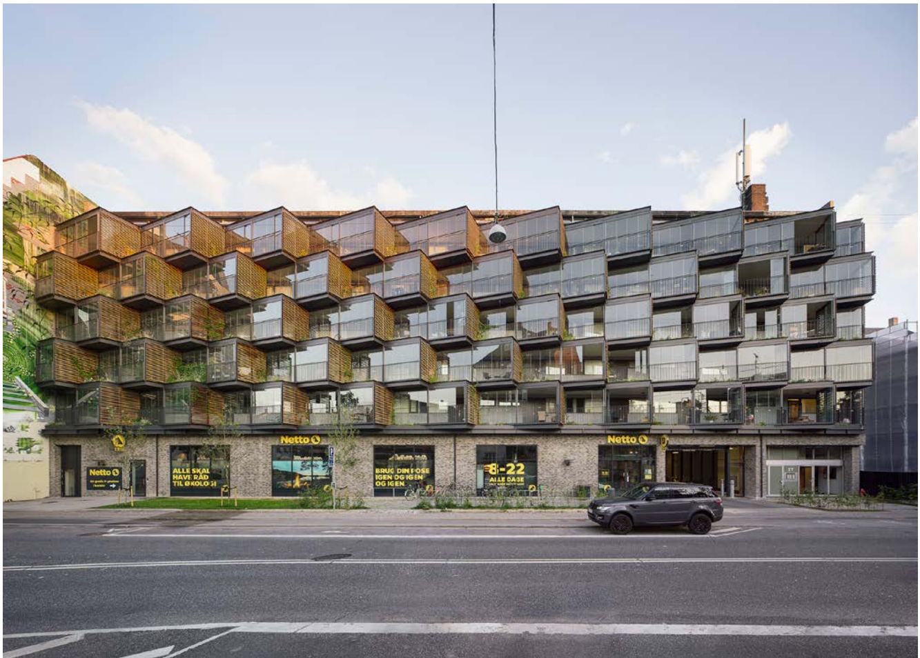
H.C. Ørstedsvvej 25-27 - Eksisterende ejendom ombygget med bl.a. ny inddækning af altangange 2019-2020
