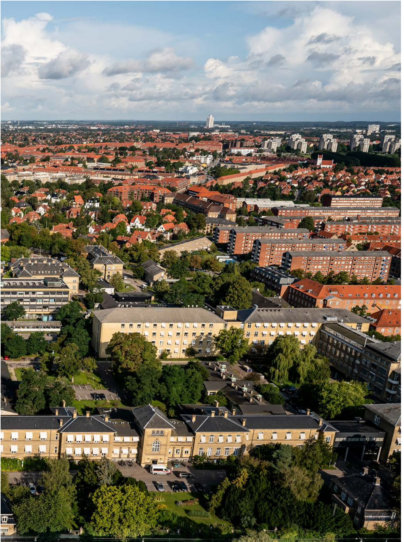
Luftfoto - Frederiksberg og Frederiksberg Hospitals område
