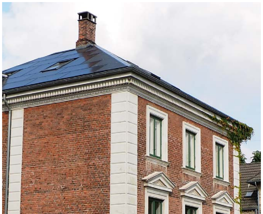
Et solcelleanlæg som er blevet integreret i taget på en villa på Rathsacksvej 25, vandt i 2018 Frederiksberg Kommunes facadepræmiering i kategorien "Den gode detalje".
