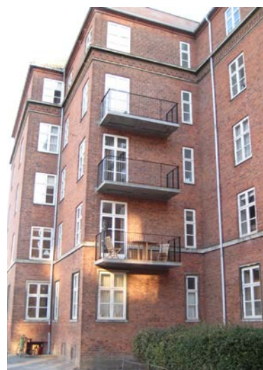
Ovenover ses 3 nye altaner på gadefacade placeret med respekt for facadens murværksdetaljer. Til venstre ses den indstøbte betonbund med fine profileringer i bunden. Steenstrup Allé 13-17/Rosenørns Allé 27A.
