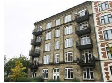
Kong Georgs Vej 6A. Gesimsbånd på 1. og 4. sal er bevaret mest muligt, ved isætning af 1-fags altandør.
