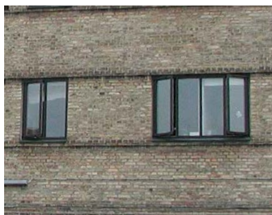
Efter 1930: Samme facadeudtryk til gade og gård på Godthåbsvej 114-116. Både gade og gård i blank mur med fremtrukne murstensbånd over og under vinduer. Funktionel tradition.
