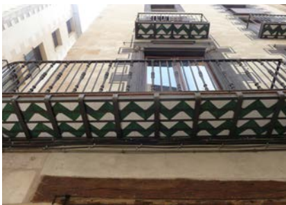
En smuk og kunstnerisk bearbejdet altanbund, som bidrager til ejendommens arkitektur og fornemt lever op til opgaven som bygningens 6. facade. Barcelona.
