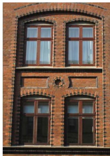
Smukt bearbejdet murværk der giver facaden dybde og spil mellem lys og skygge. Eksemplet er fra Rolfsvej 7.
