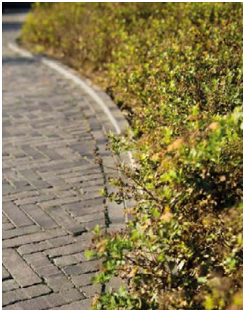
Nedsænket brændt teglclinke, som kan aflede vand.
