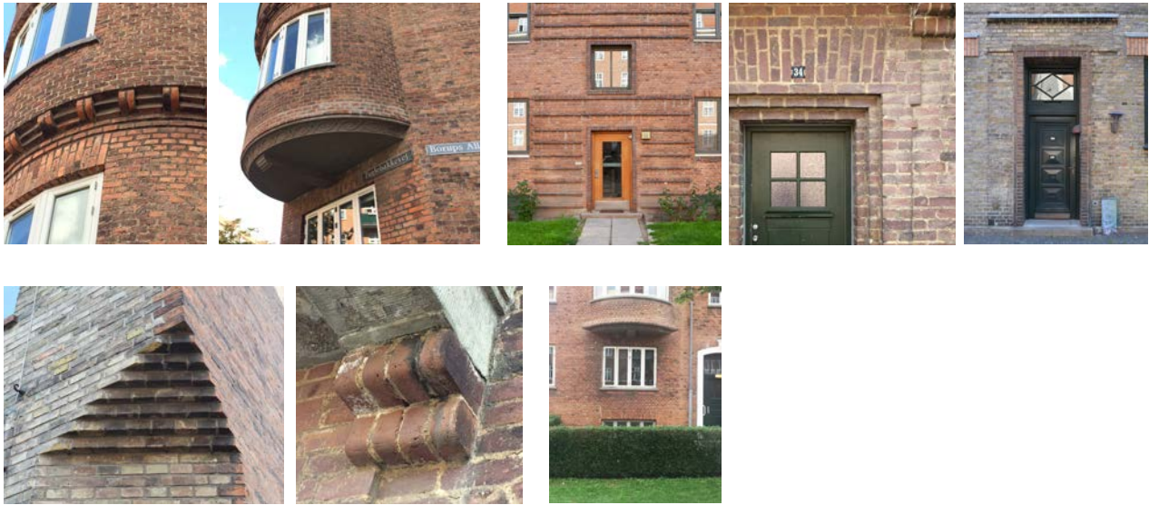
Detaljer i murværket ved den eksisterende bebyggelse Fuglebakkevej 86 og Borups Alle 136-140.
