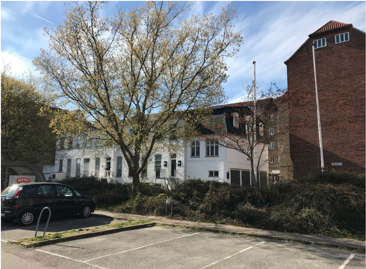
5. Eksisterende erhvervsbygning på Fuglebakkevej 88.
