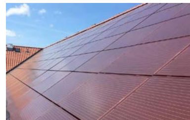
Eksempel på solceller, der er integreret i tagfladen.
