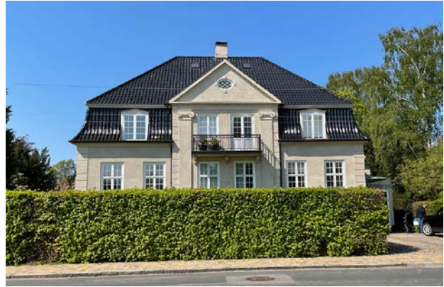
Carl Feilbergs Vej 10, opført 1922. Nybarok/palæstil. Arkitekt H.P.N. Hedemann
