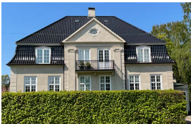
Carl Feilbergs Vej 10 fremstår med mansardtag i sortglaseret tegl. Stilarten er nyklassicismen og palæstil, der kan ses som en overgangsperiode mellem historicismen og funktionalismen. Bygningen er opført i 1922.
