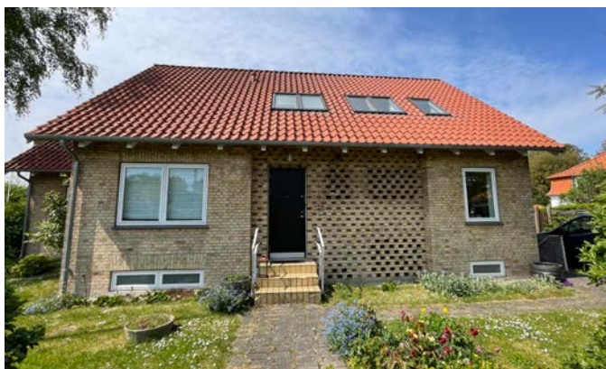
Vinduer med store glasfelter, enkle døre og dekorativ indramning af hoveddøren er et benyttet arkitektonisk motiv i perioden. Som her villa Jyllandsvej 42, opført i 1949 og tegnet af arkitekt Emil Hansen.
