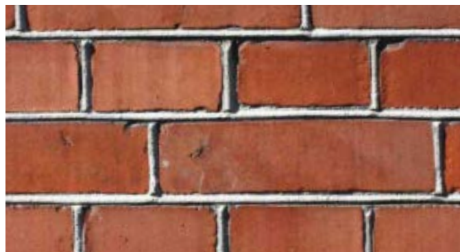
Blank mur med oprindelige "brændte fuger", som giver den murede facade en fin reliefvirkning og et smukt spil til overfladen til de glatte maskinsten. Metoden gav fugerne en meget lang levetid, fordi fugens overflade blev helt lukket af brændingen.
