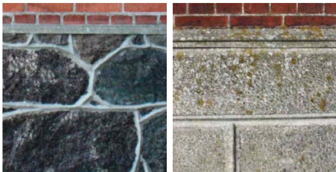
Sokkel tv. i granit og til th. cementsokkel med kvaderlignende mønster
