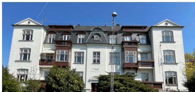
Karnap med balkon, Blytsvej 8A+B
