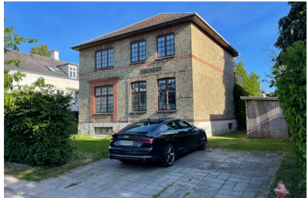
Dronningensvej 19, opført 1900. Historicisme. Bygmester Tømrermester H. Christensen
