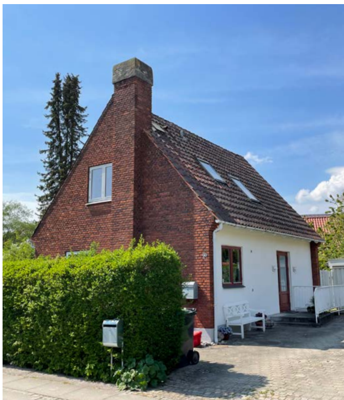
Et arkitektonisk virkemiddel man ofte så var "materialeskift", som her blank rød murstensfacade og pudset facade, der sammen med den synlige skorsten i gavlen skaber en komposition. Huset Jyllandsvej 60 er tegnet af arkitekt Knud Wolsgaard i 1953.
