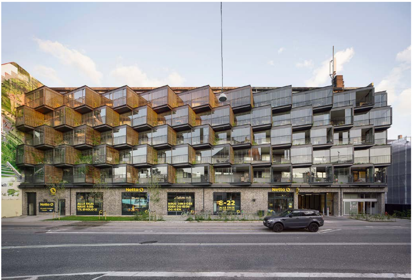
H.C. Ørstedvej 25-27 - Eksisterende ejendom ombygget med bl.a. ny inddækning af altangange 2019-2020
