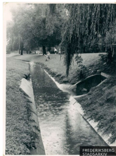
Overløbsrenden (1952) ved Grøndalsengen før overdækning, som af hygiejniske grunde udførtes 1952-53. (kbhbilleder.dk)
