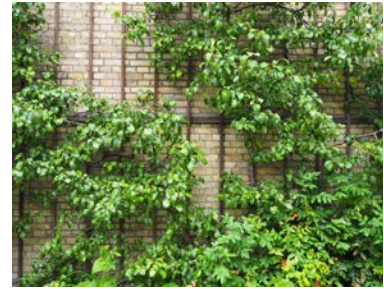
Flere steder er facadebeplantning oprindeligt støttet af trælamel-espalierer
