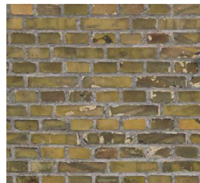
Eksisterende tegl, renses og udbedres hvor nødvendigt
