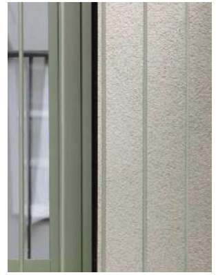
Vinduesrammer udføres i en sart grøn nuance
