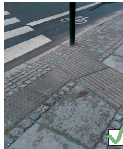
Figur 43. Fodgængerfelt med skævt retningsfelt for anvisning af feltets retning
