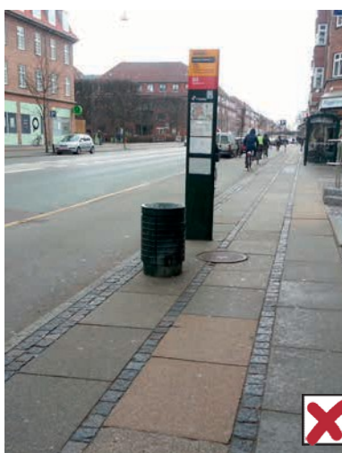
Figur 39. Opmærksomhedsfelt mangler ved indstigning til bus
