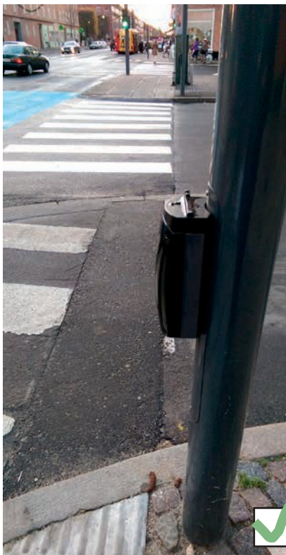
Figur 44. Akustisk signal med retningsgiver
