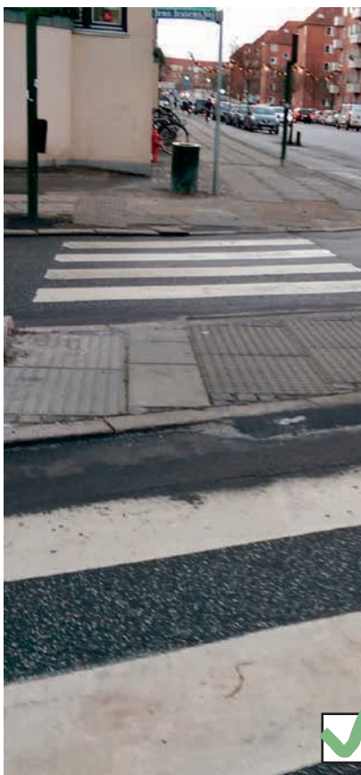
Figur 35. Korrekt udført retnings- og opmærksomhedsfelt i fodgængerhelle
