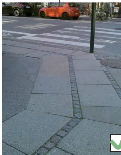
Figur 42. Korrekt udformet fortovs-hjørne
