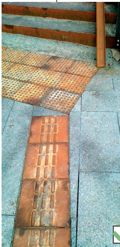
Figur 45. Retningsstreg og opmærksomhedsfelt til trappe ved flintholm station
