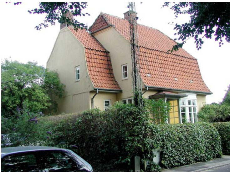
Et anderledes tag i kvarteret, med en mansardlignende* opbygning i både hovedhus og tilbygning. Buen 16
