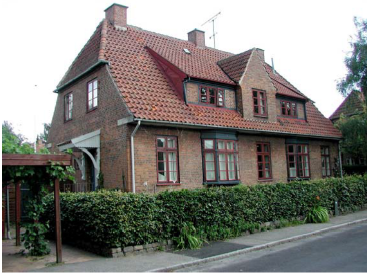
Stor tagflade, gennembrudt af to pultkviste*, én på hver side af en fronton*. Taget er halvvalmet* over gavlene. Buen 14-16
