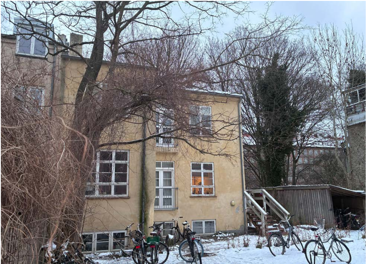
Før: Eksisterende baghus Mariendalsvej 22B, som bevares. Foto fra gården
