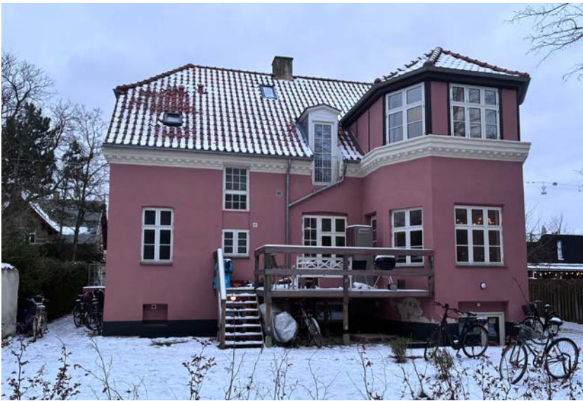
Foto af forhusets bagside set fra gårdrummet
