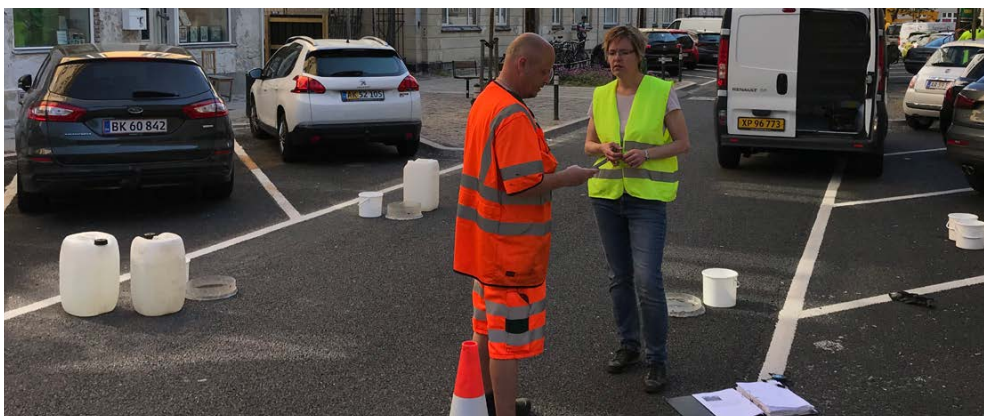
På Ærøvej testes infiltrationsevnen af den permeable asfalt.
