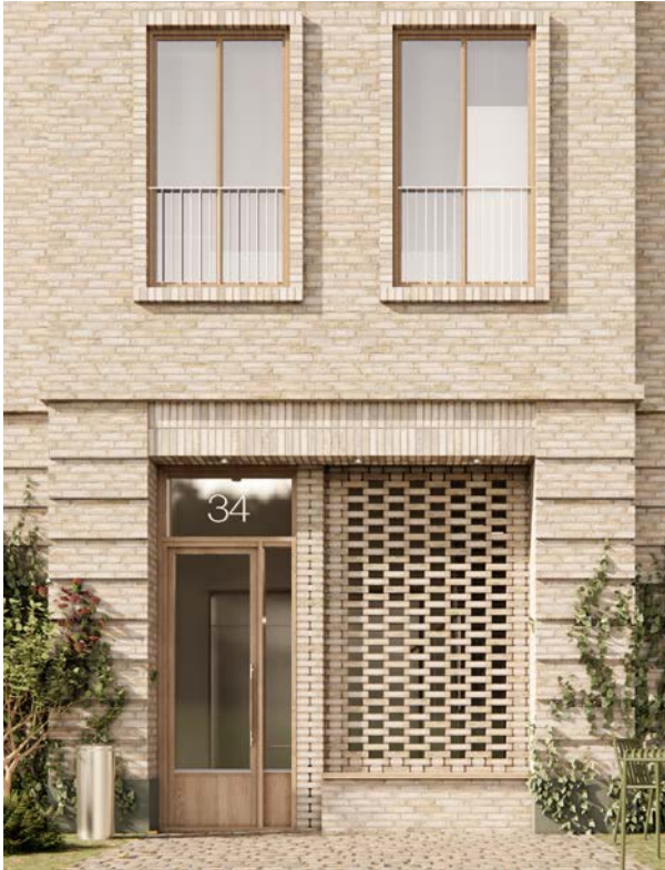
Ny bebyggelse mod Platanvej og Henrik Ibsens Vej skal have murdetaljer i form af bånd og partier med lodretstillede mursten. Markiser til erhverv skal være ensfarvede.
