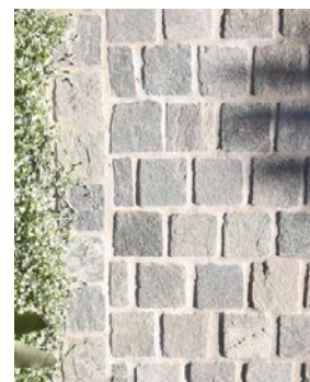
Chaussésten i gårdrum
