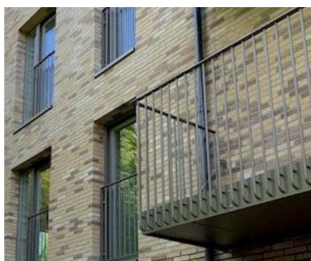
Altanreference: Balustre der går ned over altanvange/siden af altanbunden og ned til bunden af bundpladen.
