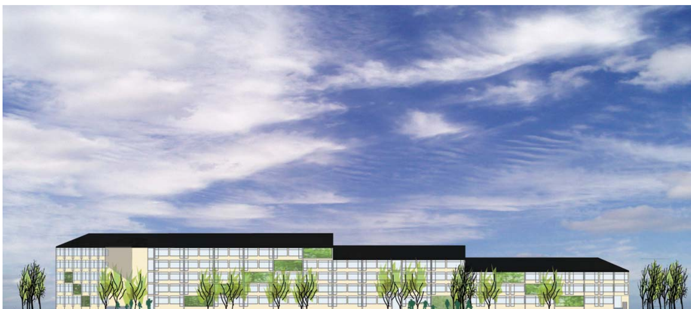
Facade mod vej
