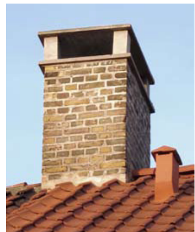
Referencefoto af skorsten med oprindelige dimensioner, materiale og vandret dække.
