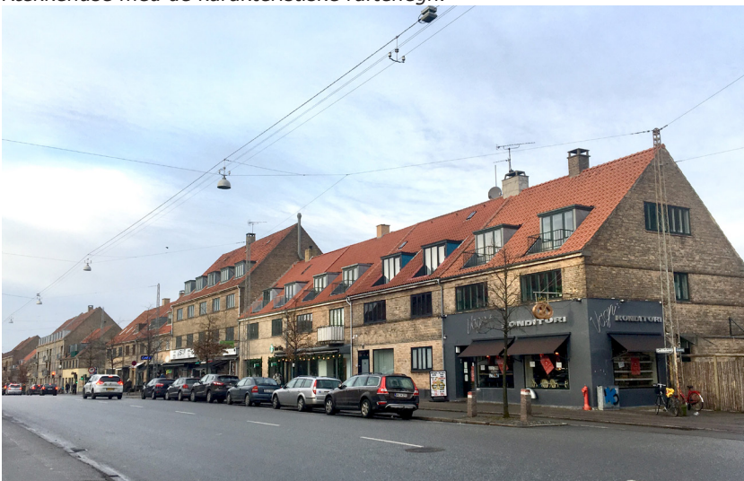
Fra Godthåbsvej 78-94 Bygning i 3½ etage med portgennemgang.
