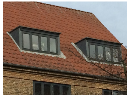
Referencefotos af smal kvistflunk (siden af kvisten) beklædt med zink.
