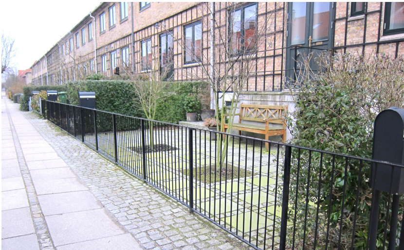
Rækkehuse på Drosselvej med forhaver med metalhegn.
