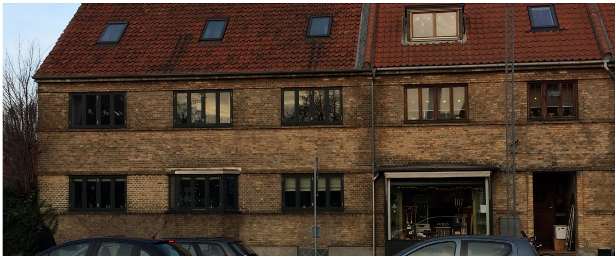
Referencfoto af vinduestyper mod Godthåbsvej, karakteriseret ved indramningen af vandrette murbånd.
