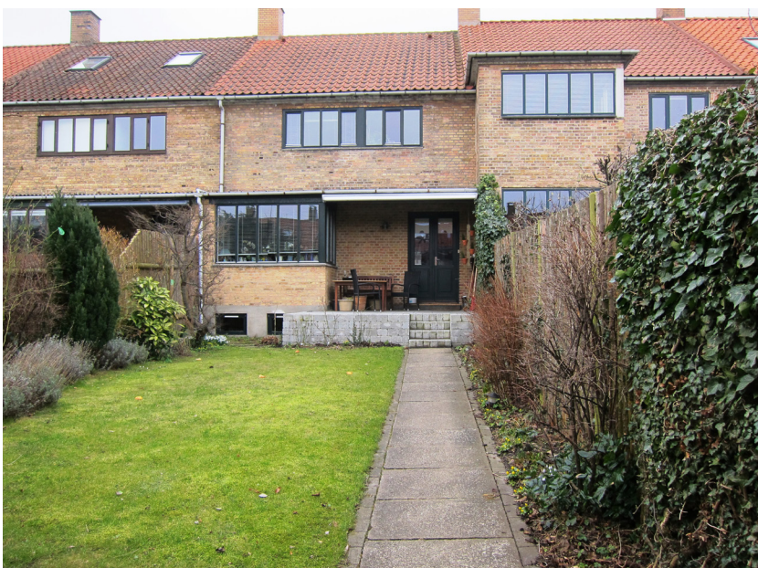
Rækkehuse ved Solsortvej 34..
