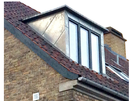
Referencefotos af smal kvistflunk (siden af kvisten) beklædt med zink.
