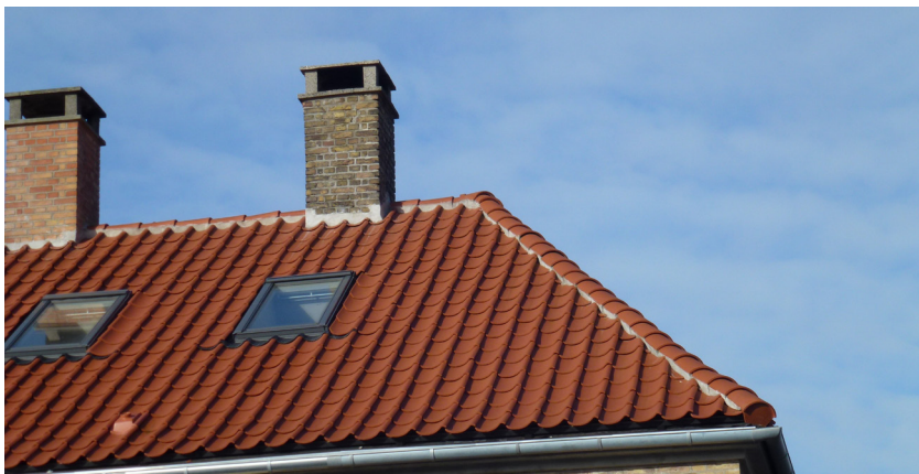
Referencefoto af valmsten i glat model, lagt i bakkemørtel.
