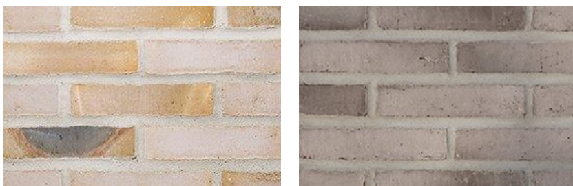
Figur 11. Facademidten udføres i blødsrøgne teglsten i lyse sandfarvede nuancer med et farvespil som skaber variation i facadeudtrykket. Basen udføres i blødsrøgne teglsten i mere grålige nuancer samt en smule mørkere end facademidten og markeres med recesser i murværket.
