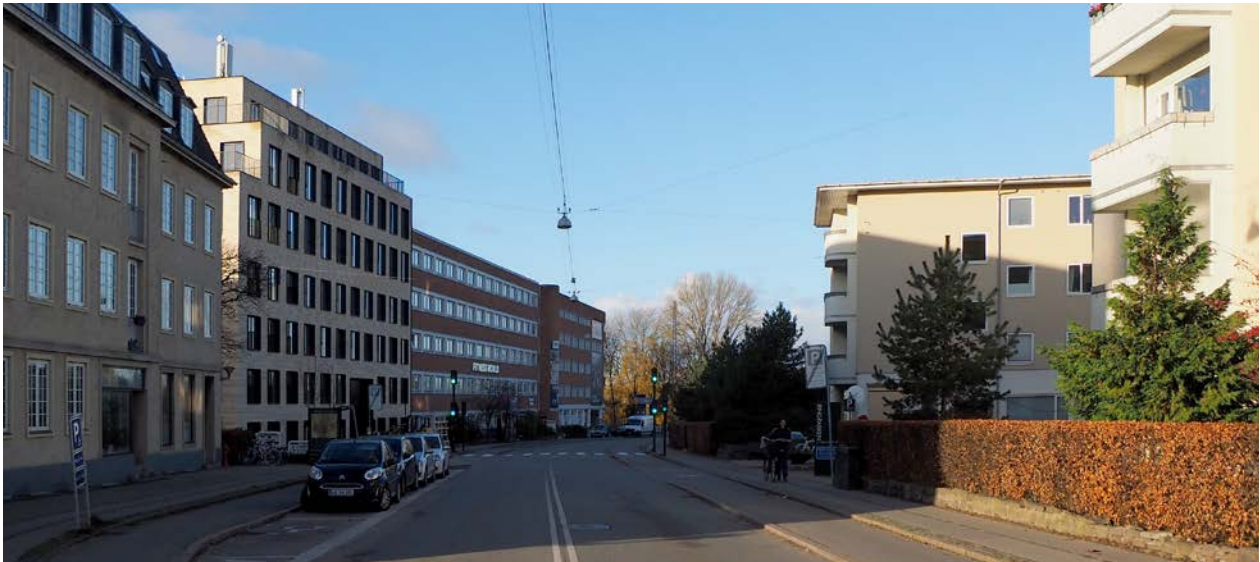
Figur 6. Kig ned ad C. F. Richs Vej fra øst mod vest. Den eksisterende røde kontorejendom ses bagest i venstre side og Ringparken i højre side.
