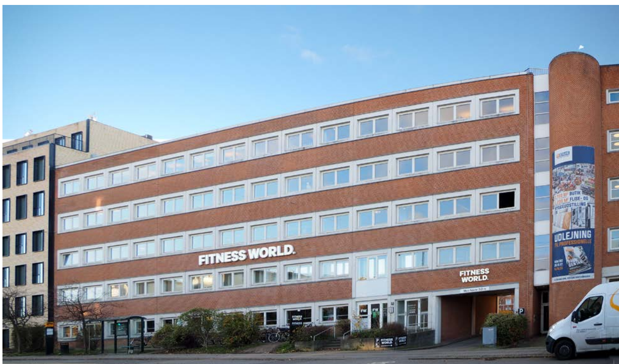
Figur 8. Foto af nordlig bygnings eksisterende nordvendte facade mod C.F. Richs Vej. Fra venstre mod højre del af C.F. Richs Vej 105, i midten nr. 107 (projektområdet) og mod højre, del af STARK's eksisterende ejendom nr. 109.
