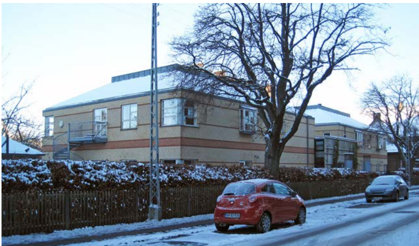
Den eksisterende SFO-bygning vender ryggen til Duevej. Langs skoleområdet er i øvrigt en 5 meter bred hækplantning, der i høj grad er med til at lukke skoleområdet af for omgivelserne.
