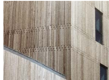
Eksempel på facade i træ, hvor samlinger er med til at give bygningen karakter og detaljerigdom.
