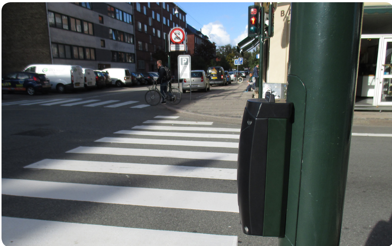
Akustiske signaler i krydset Nordre Fasanvej/Mariendalsvej.
