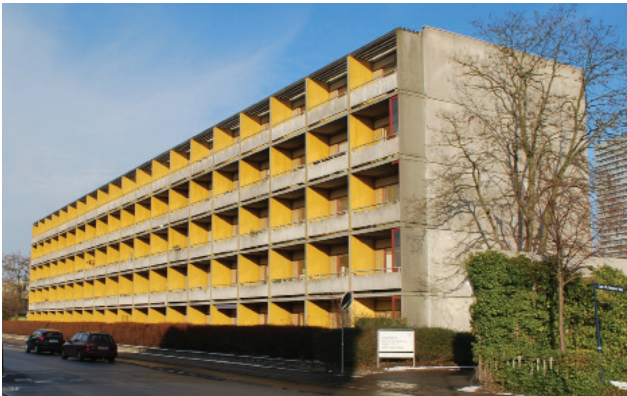
Del af den eksisterende bygning - facade mod vejen Skellet
