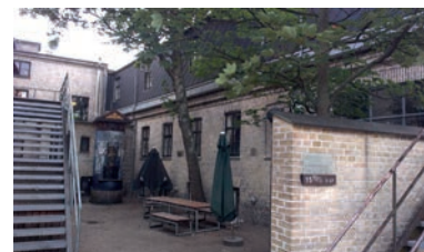
Illustrationen viser bygningen, der støder op til lokalplanområdet. Den huser i dag studentercafe i tilknytning til Studenterhuset.
