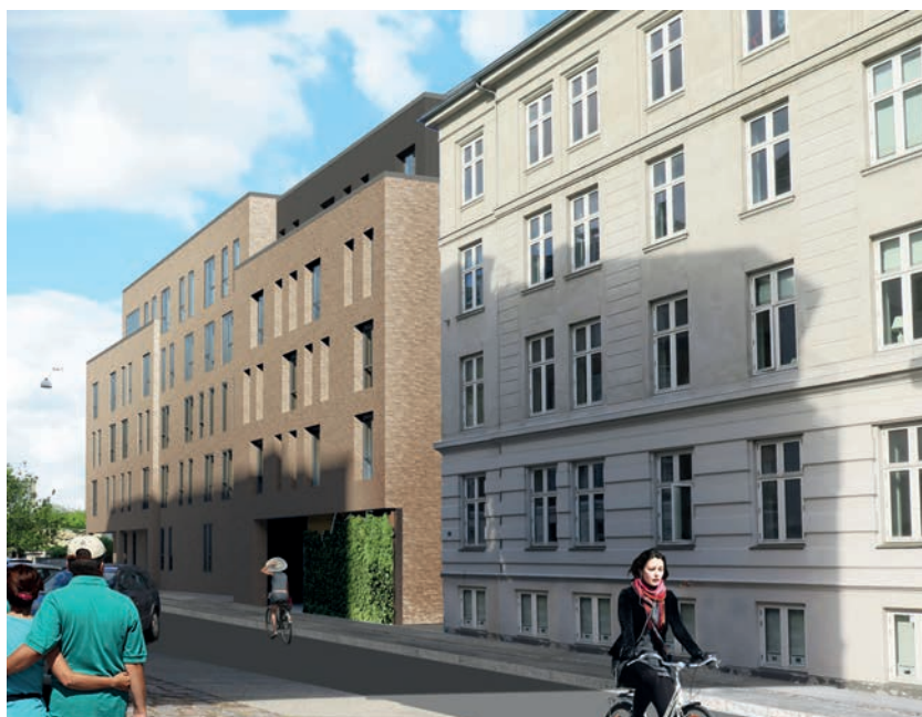
Illustrationen viser projektet set fra Grundtvigsvej og hvordan det indpasses i gadebilledet med fremrykninger, højder og skift i stueetagen samt tilbagerykning af øverste etage på den smalle del af gaden.
