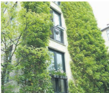
Klatreplanter på facaden.
