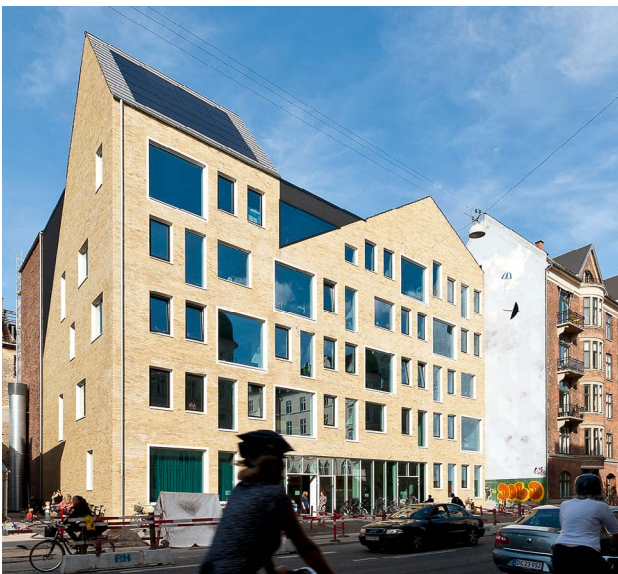
Skolen på Bülowvej (ovenfor) (CEBRA arkitekter) I 2009. Store vinduer kaster lys ind i klasselokalerne. Solceller på taget medvirker til at forsyne bygningen med strøm.
