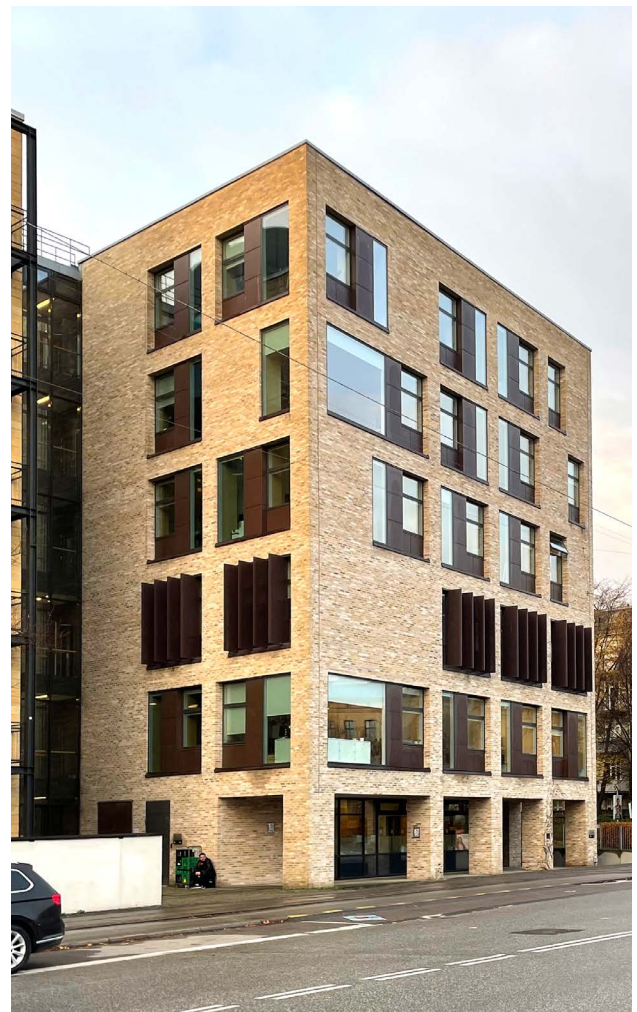
Fødevarerbygning Rolighedsvej, KU Science (th) (Wiberg Arkitekter/ZESO arkitekter) Bæredygtigt og energioptimeret design og energiforsyningen, en kombination af passiv- og lavenergikoncept. Selvforsynende med varme. Solceller på taget producerer 11.720 kWh/år. Præmieret af Frederiksberg Kommune, for godt og smukt byggeri 2015
