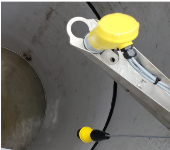
Figur 4: Niveaumåler i opsamlingsbrønden
