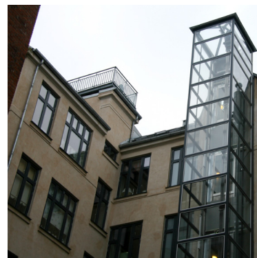
Etablering af tagaltan i forbindelse med opsætning af elevator.
