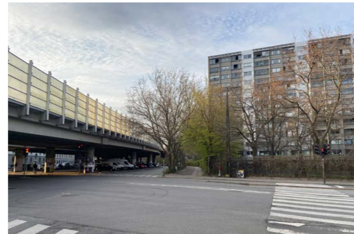
Lundtoftegadebebyggelsens højhuse ligger tæt på buen.
