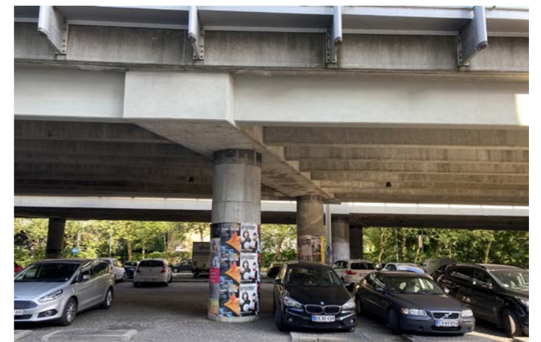
Parkering under den sydlige del af Bispeengbuen.
