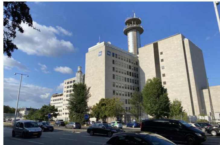
Telefonhuset opført i 1950'erne set fra Ågade.
