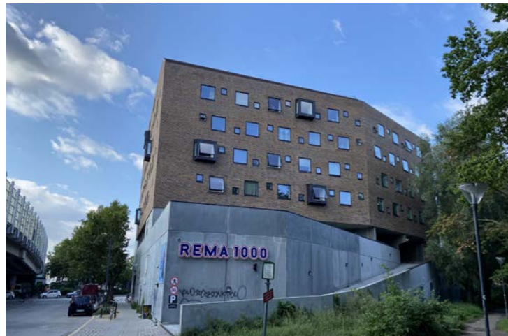
Nybygget supermarket og ungdomsboliger ved Nrd. Fasanvej.
