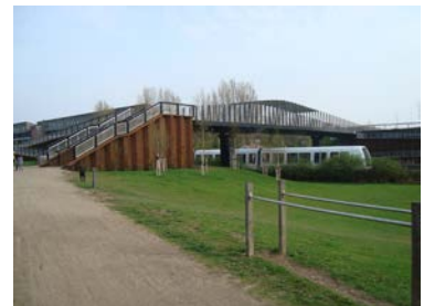
Stibroen med trappe- og rampeanlæg set mod øst.
