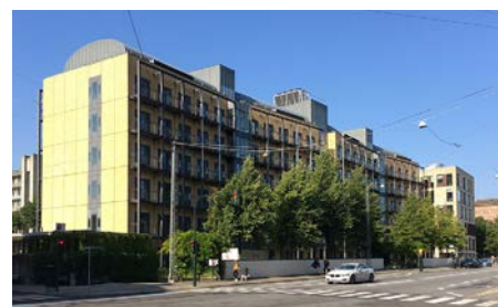
7) Københavns Universitets bygninger ved Rolighedsvej 26-30.
