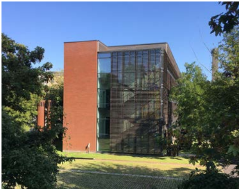
15) Rød laboratoriebygning i 4 etager.
