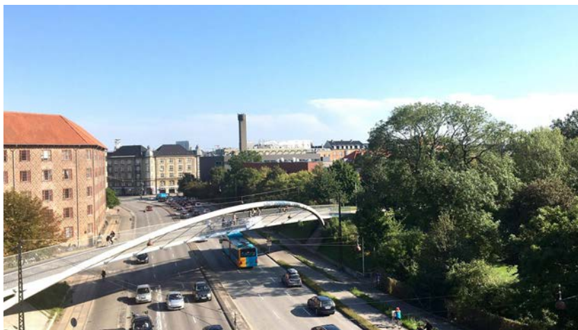
1) Åboulevard, cykel-/gangbro og nordlige del af lokalplanområdet til højre.
