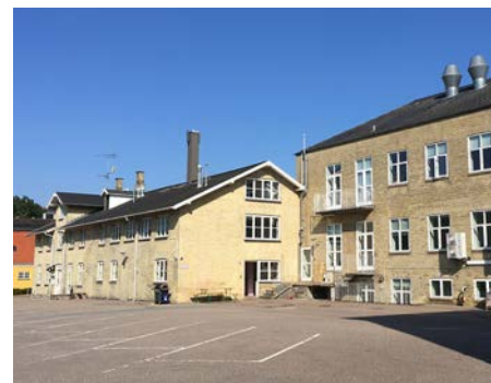
13) Længer i 2-3 etager bag Rolighedsvej 39.
