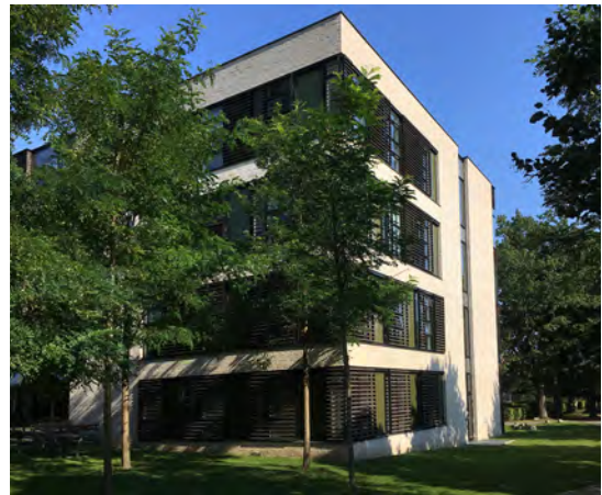
9) KU's bygning ved Rolighedsvej 25.
