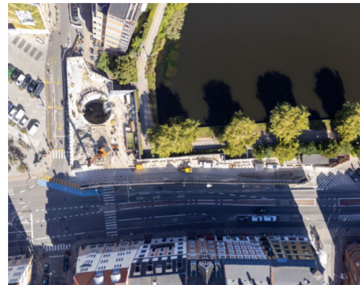
Kalvebod Brygge Skybrudstunnel på hjørnet af Vodroffsvej og Gammel Kongevej.
