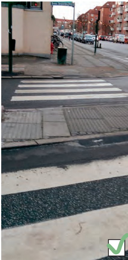
Figur 35. Korrekt udført retnings- og opmærksomhedsfelt i fodgængerhelle
