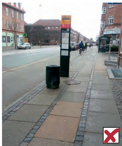
Figur 39. Opmærksomhedsfelt mangler ved indstigning til bus
