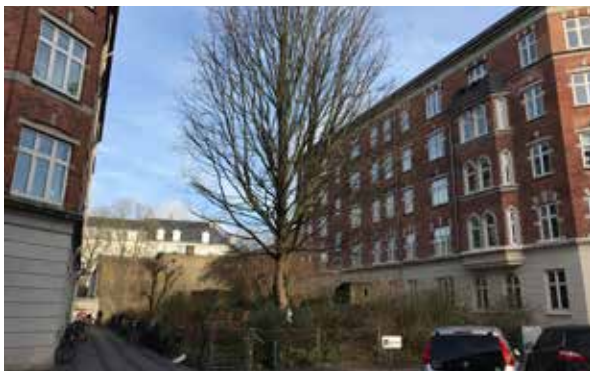
7: Bunkeranlæg og lindetræ mellem Holger Danskes Vej 88 og 90.
