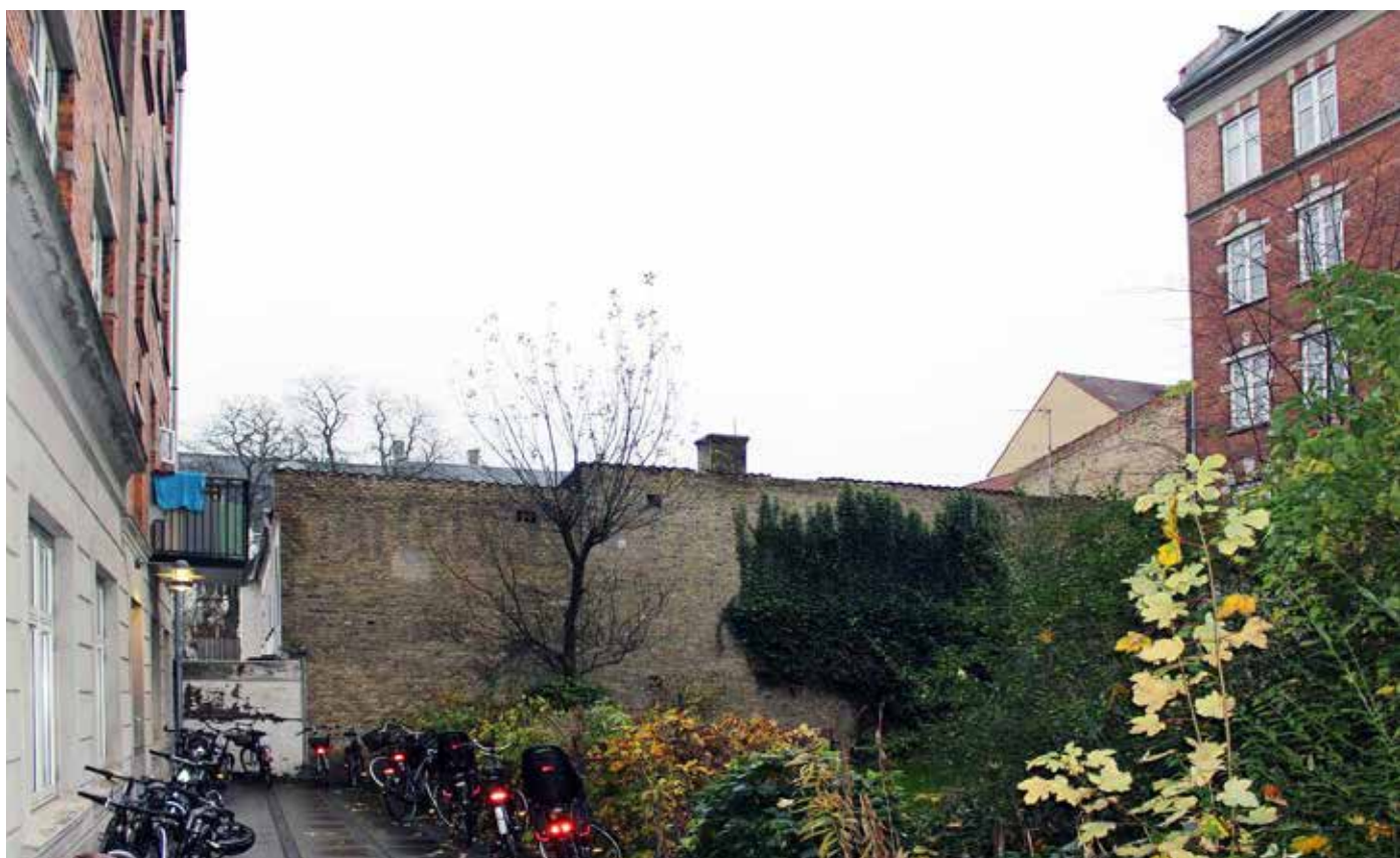
Kig fra Holger Danskes Vej mod haverum med mur - eksisterende forhold
